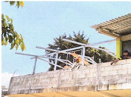
Foto 3: Mejoramiento de estructura de tipo pórtico e instalación de lámina troquelada calibre 26.
