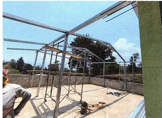
Foto 4: Mejoramiento de estructura de tipo pórtico e instalación de lámina troquelada calibre 26.
